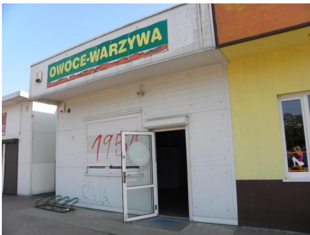
Fotografia 6 Sklepy na terenie Placu Handlowego w Gorzycach
